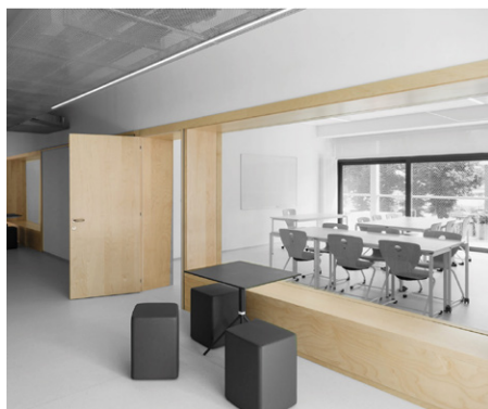
Sistema di vetrata fissa interna con annessa seduta in legno
