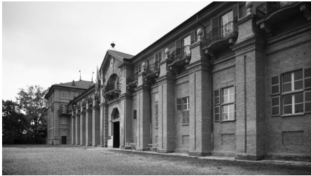
Borgo Castello facciata principale // principal facade
